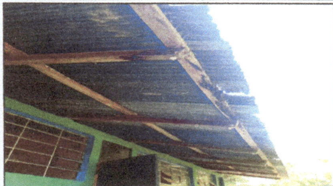
Foto1: Sustitución de láminas acanaladas por troqueladas
