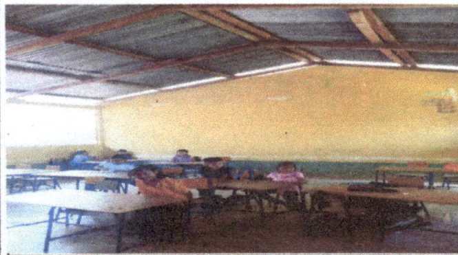
Foto 3: Sustitución de soporte de madera por costanera de metal
