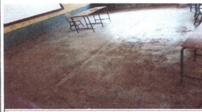
Foto 5: Instalación de piso cerámico en dos aulas
